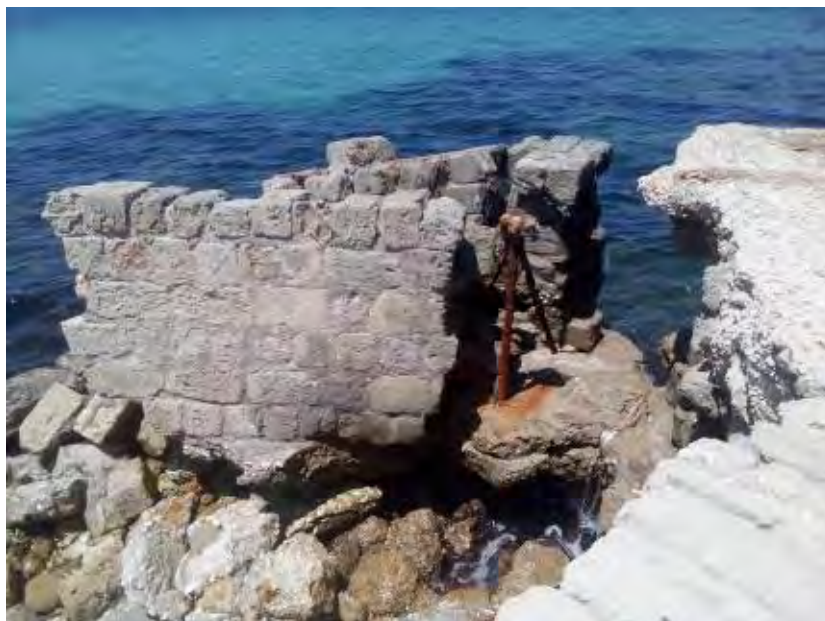
Figura 90 - MOLO – accesso parzialmente dismesso, con evidenti degradi per distacco e cedimento sull'estremità NORD OVEST
