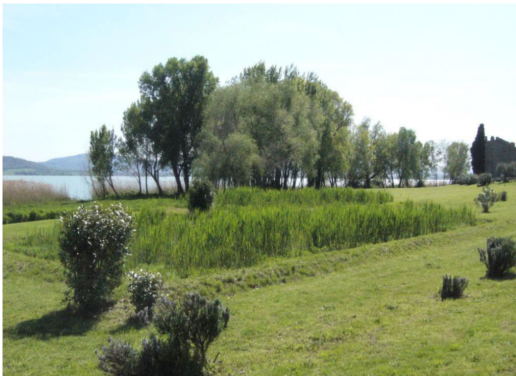
Figura 4 - Sistema di depurazione HF (100 AE) nel parco dell'Isola di Polvese - Lago Trasimeno (PG)
