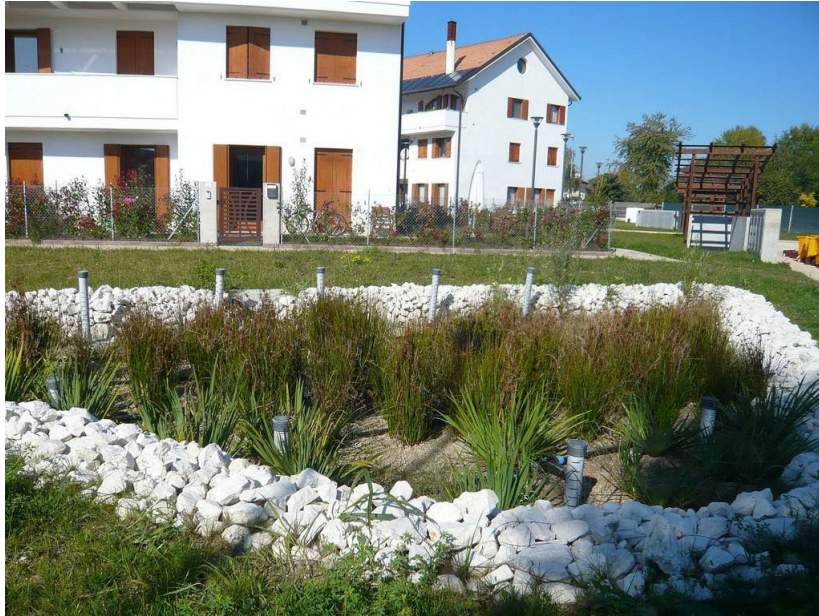
Figura 11 – Filtro vegetato per il recupero delle acque meteoriche (Preganziol, TV)
