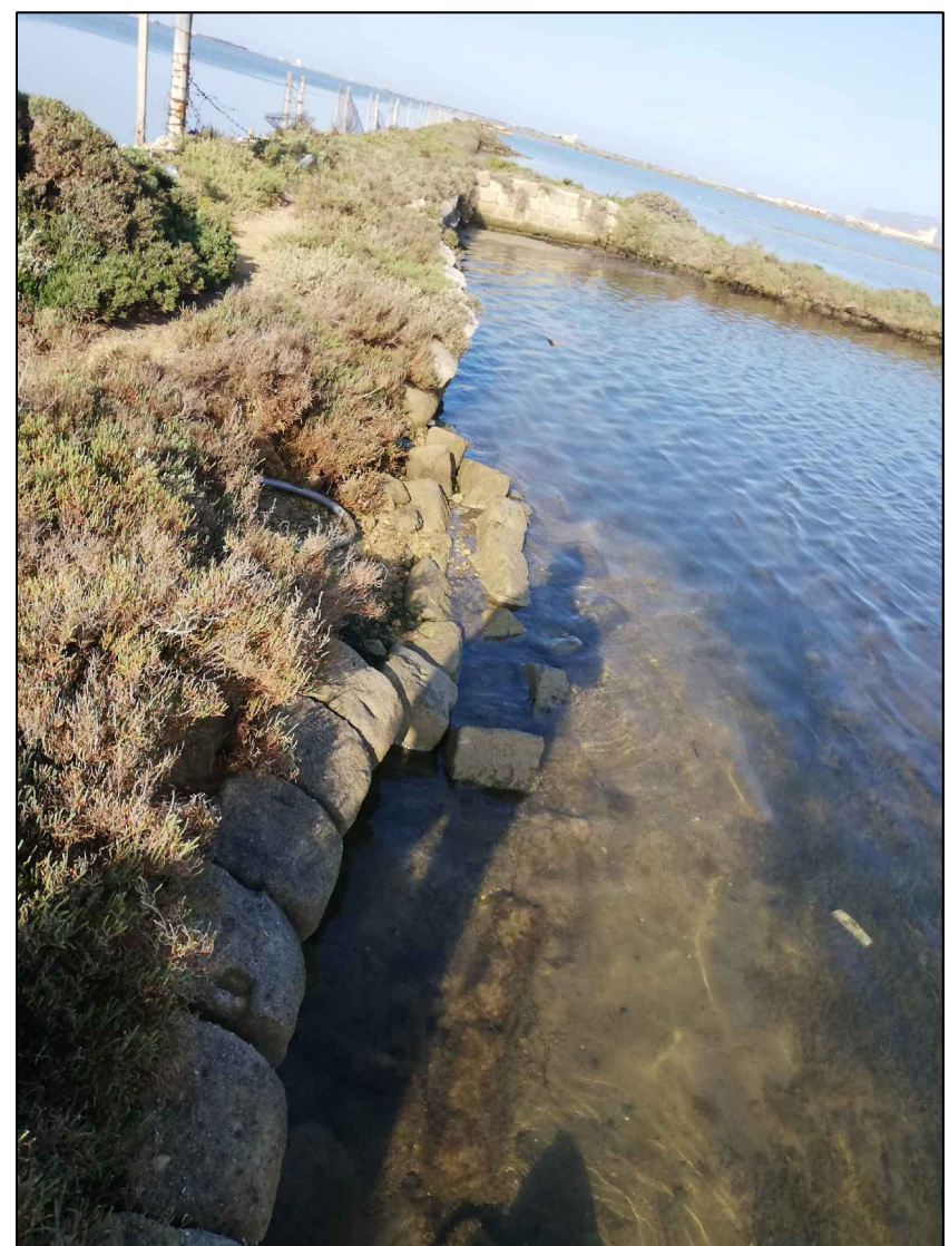
foto dei muretti di contenimento delle traverse in parte crollati
