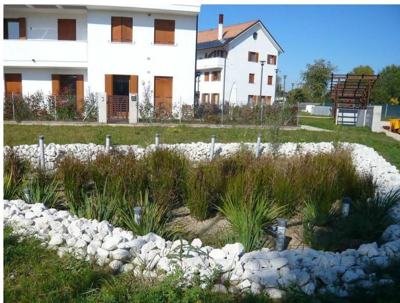
Figura 11 – Filtro vegetato per il recupero delle acque meteoriche (Preganzio, TV)
