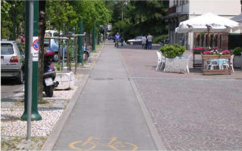
*Monodirezionale a quota marciapiede in sede propria - situazione ottimale con cambio di pavimentazioni e profili longitudinali che definiscono la leggibilità degli spazi. (Errata la colorazione del simbolo "bici" che andrebbe bianca)*
