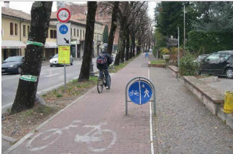
*Bidirezionale a quota marciapiede in sede propria - situazione ottimale con cambio di pavimentazioni e profili longitudinali che definiscono la leggibilità degli spazi.*
