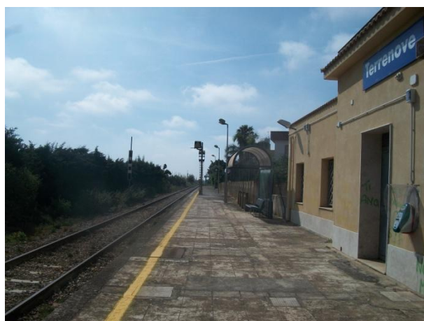
Stazione di Terrenuove
