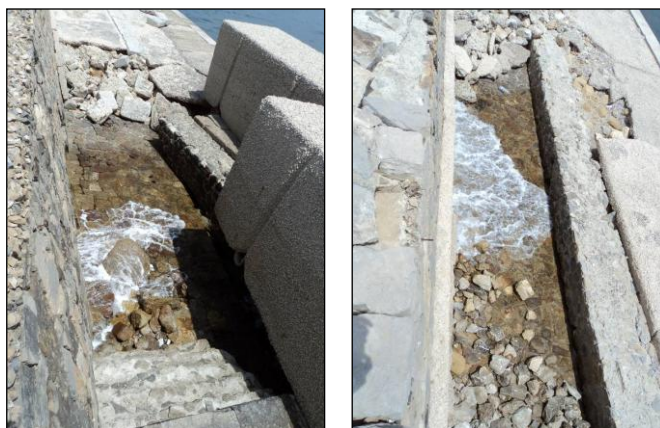
Effetti delle fessurazioni sul molo di sopraflutto
