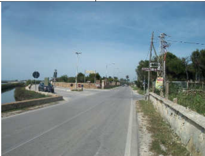
S.P. 21 (lato sud)
